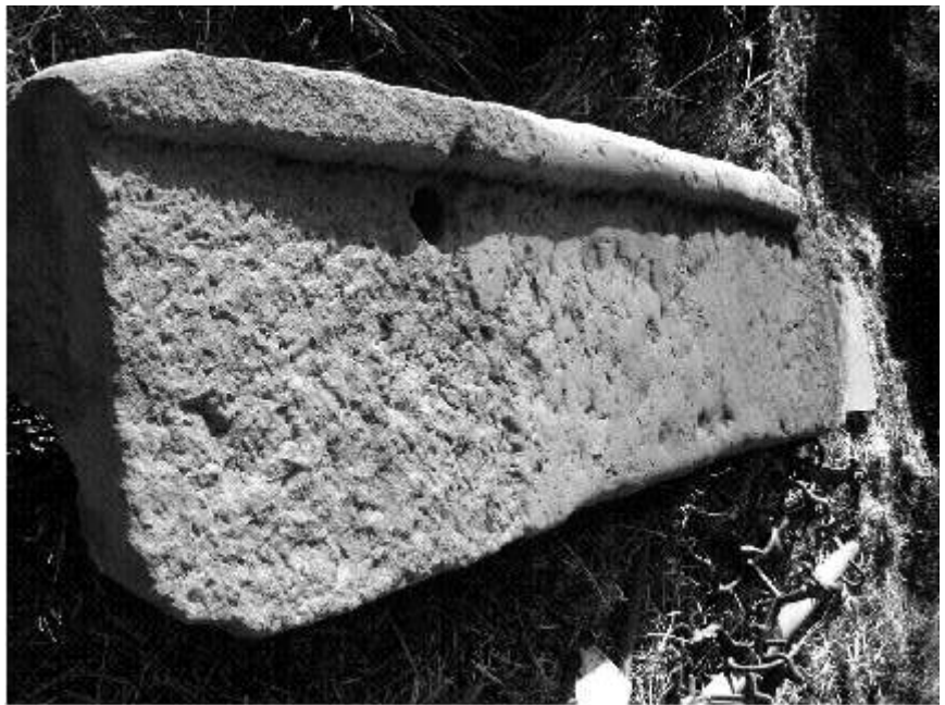
Masseria Petrilli: Soglia in pietra calcarea della zona, della Villa Rustica Romana, lunga m 2,21, larga cm 58 e spessa cm 24, con due fori laterali distanti tra di loro di cm 145, per la posa degli stipiti .
